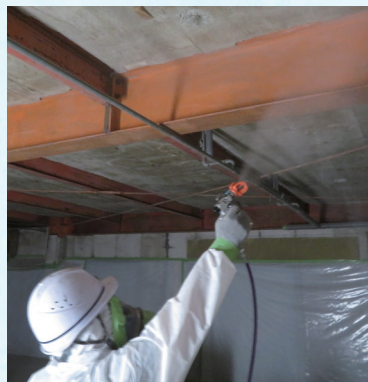
「アスベスト除去工事」
